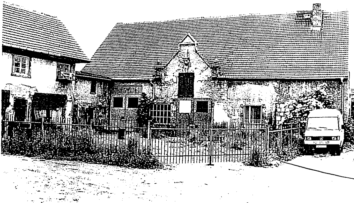
Abb. 4: „Scheune“ - Nordbegrenzung des vorderen Hofteiles Gebäude (E)
