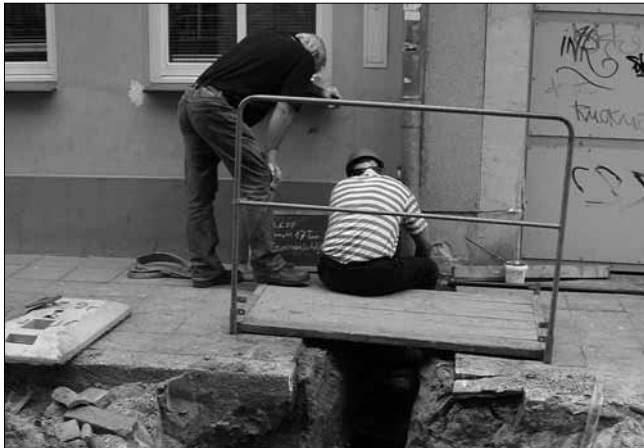
Anschluss des Regenfallrohres Haus Nr. 17
