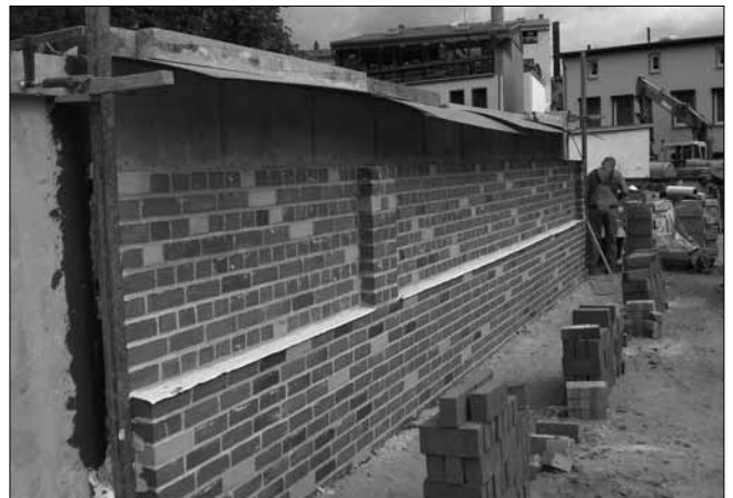
Errichtung der neuen Mauer im Friedrich-Schult-Weg, Stand: 11.06.2008
