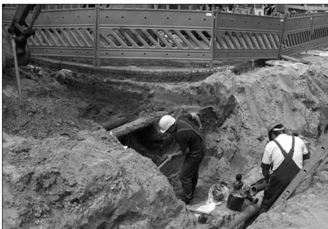
Bau der Wasserleitung im Kreuzungsbereich Grüner Winkel
