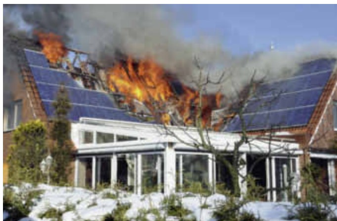
Brennende Solaranlagen werden häufig nicht gelöscht, weil die Gefahr eines elektrischen Schlags für die Feuerwehr besteht.
