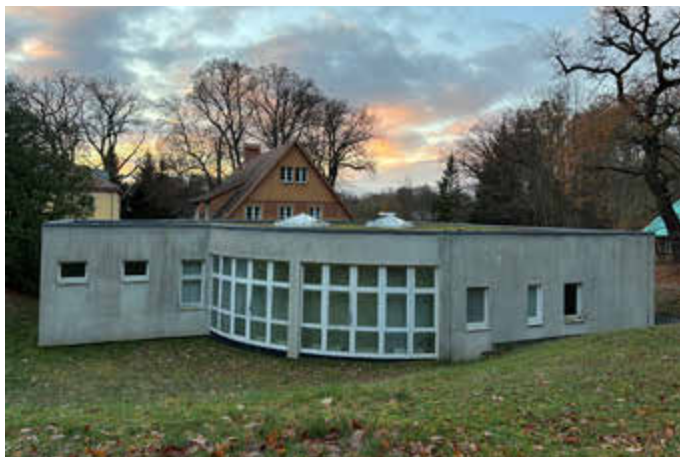
Foto: Versorgungstrakt Schabernack
