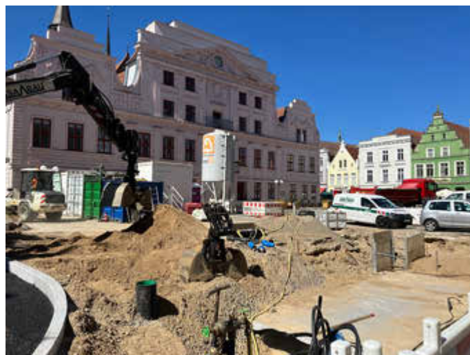
Foto: Baustelle am 13.08.2024
