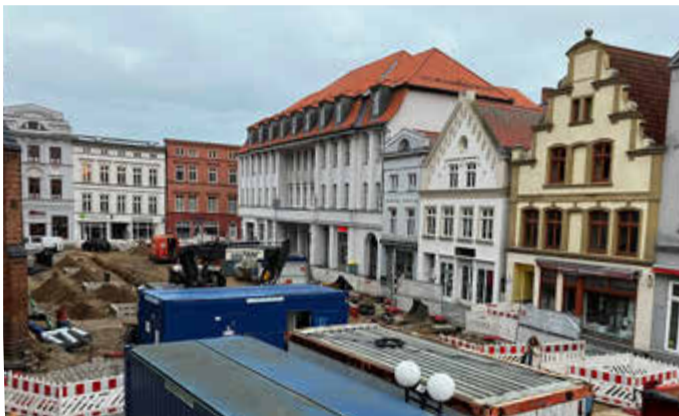
Foto: Blick auf das Baugeschehen auf der Nordseite des Marktes
