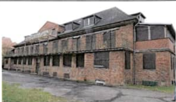
ehemaliges Säuglingsheim Goldberger Straße 9 – mit Bestand -Straßenseite
