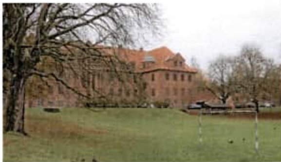
ehemaliges Kinderheim Goldberger Straße 8- Hofseite- Planung Umnutzung als Seminar – und Verwaltungsgebäude
